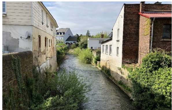
Abbildung 23: die kanalisierte Aar
