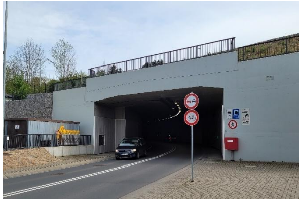
Abbildung 42: Den Tunnel können Radfahrende und zu Fuß Gehende nicht passieren
