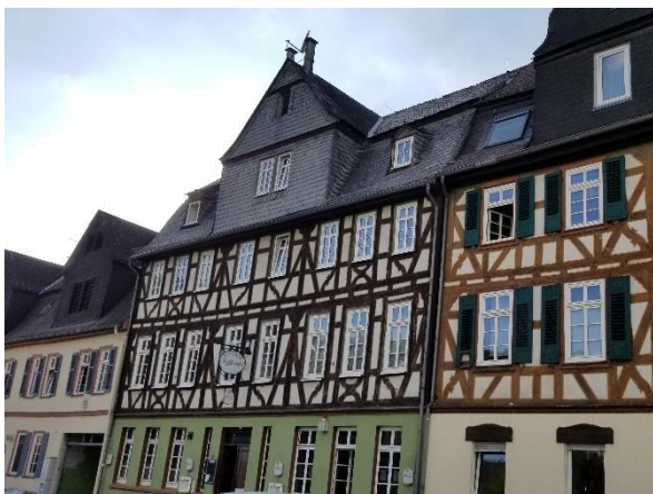
Abbildung 28: Die Gebäude in der Schulstraße sind überwiegend besonders gut erhalten
