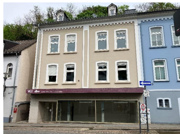
Abbildung 19: ein weiterer Leerstand im Erdgeschoss
