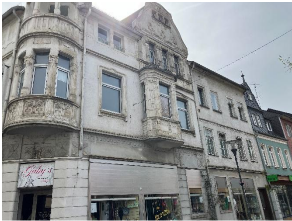
Abbildung 26: Das Eckhaus am Eingang der Altstadt ist in einem sehr schlechten Zustand
