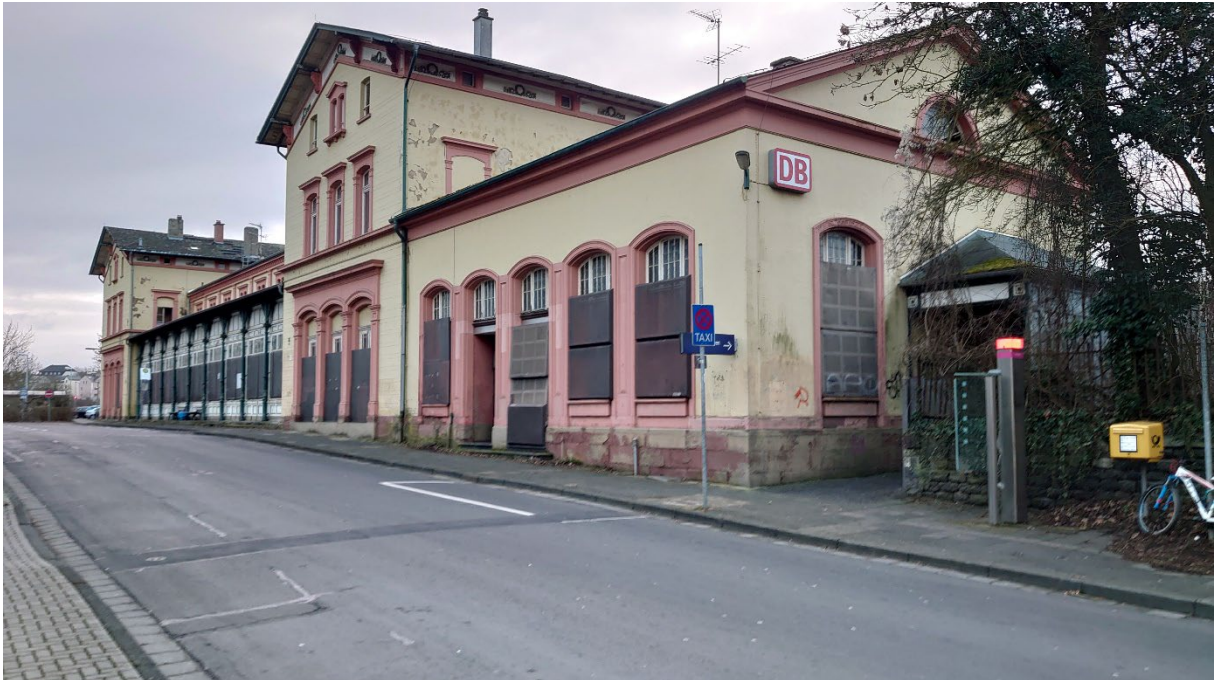
Abb. 16: Ansicht des Bahnhofsgebäudes in Diez von der Straße
